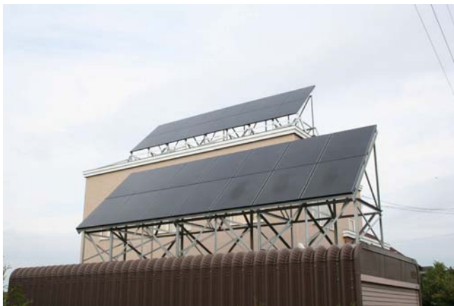
写真 設置が完了した太陽光パネル
